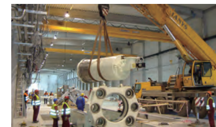
押出プレスの移設工事
