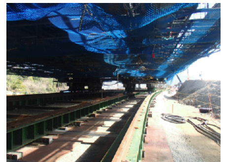
写真-1 軌条設備の設置状況
