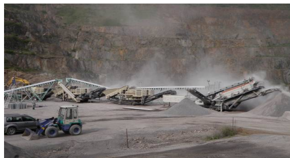
写真2 ロコトレインシステム稼働状況
