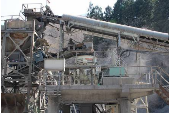
写真1 HP3 設置状況
