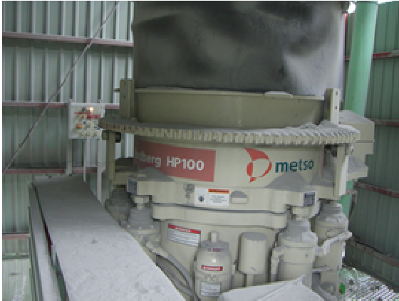
写真4 HP100設置状況
