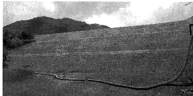
9月に完成した土留かん止堤
