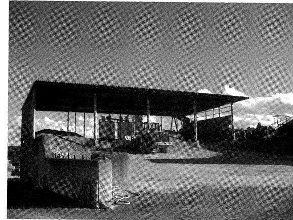
骨材の仮置き場
