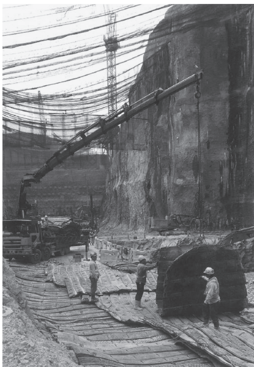
写真1 フリントストーン・マイニング・サービス社は都会での発破や繊細な地域での発破のために、発破マットを輸入しました。
