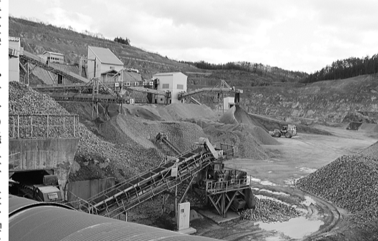
北日本採石興業のプラント設備と切羽
