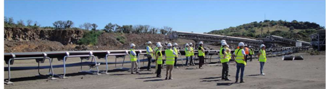
写真-⑧ 仮設ベルトコンベヤ写真
