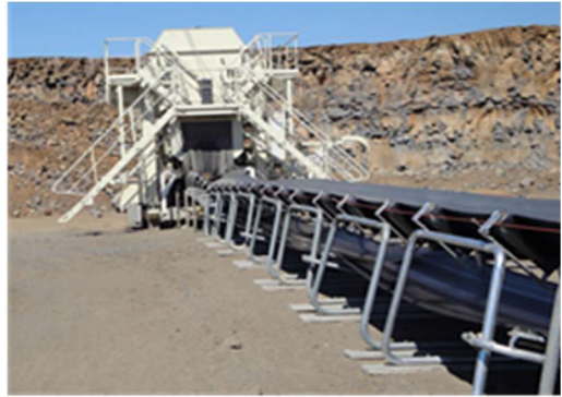
写真-⑦ 仮設ベルトコンベヤ写真
