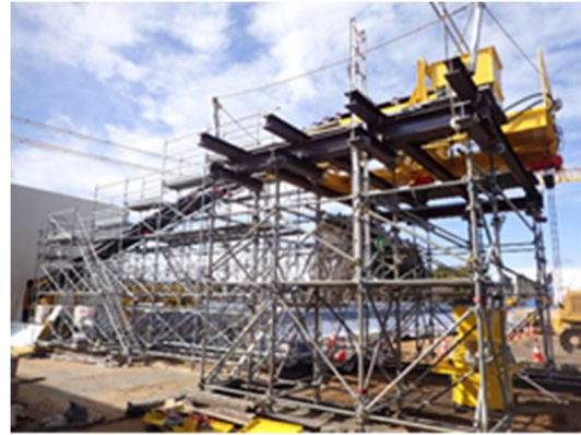
写真④ 仮設資材ヘッド例
