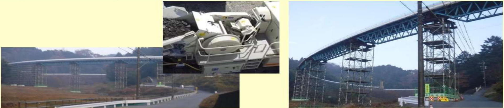
図6 A社納入、稼働中の電動破碎機、フリーラインコンベ
