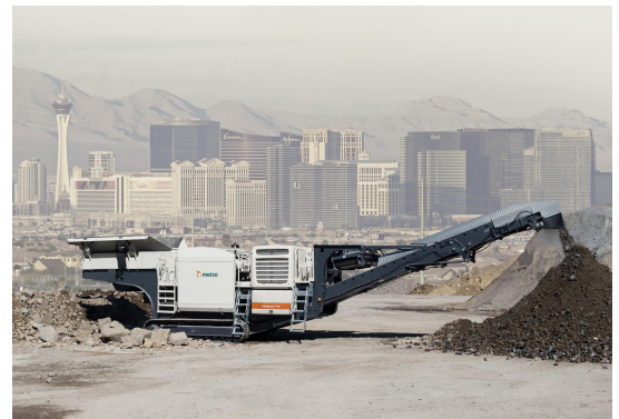
図 11 都市部の解体処理現場で稼働中の LT106
