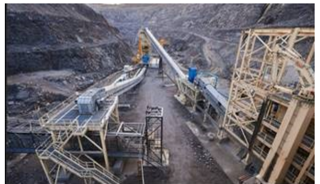
図10 建設中のC150クラッシュステーション
