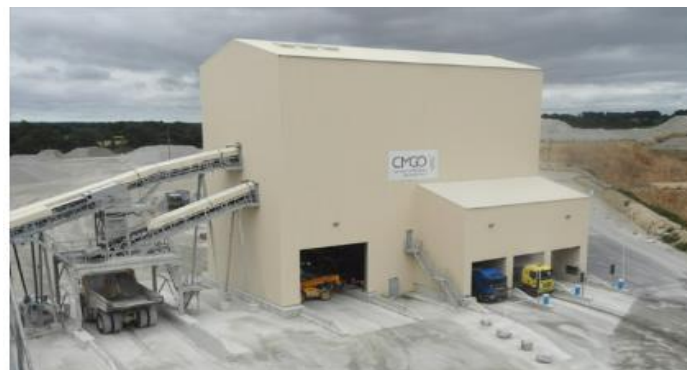
図13 自動出荷装置外観
