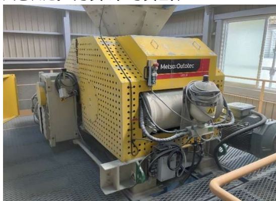
写真1．HPGR8設置状況
