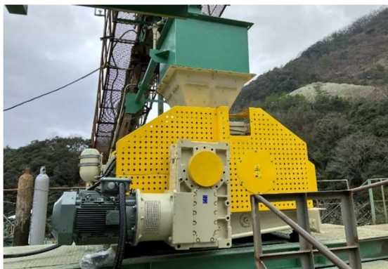
写真3. HPGR8設置状況
