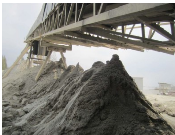
図5 ベルトコンベヤ落鉱例
