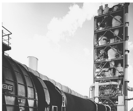
Fig. 3 宇部興産機械の製品：セメントキルン
