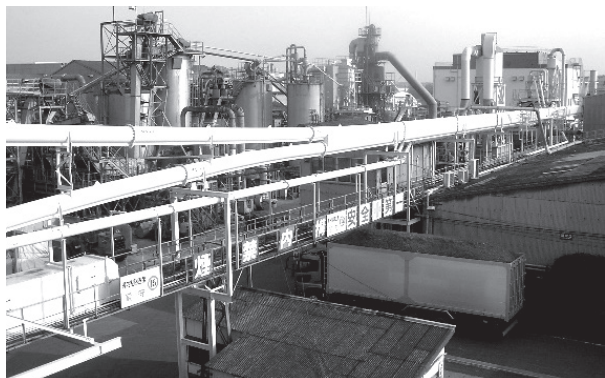
写真4 エア浮上コンベヤ【当社の製品】
