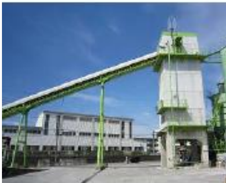
生コンプラント全景
