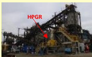
図2 HPGR実機外観
