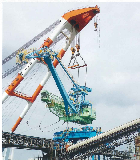
旋回部据付状況
