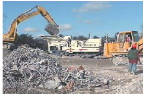
コンクリートリサイクル
