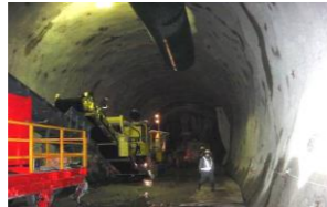
トンネルズリ破碎
