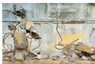
コンクリート解体
