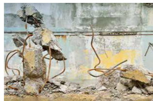
コンクリート解体
