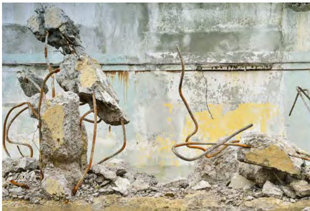
コンクリート解体
